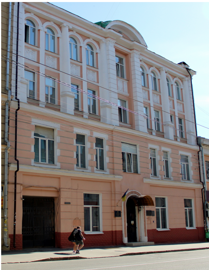
Будівля Державного архіву просп. Московському, 7
